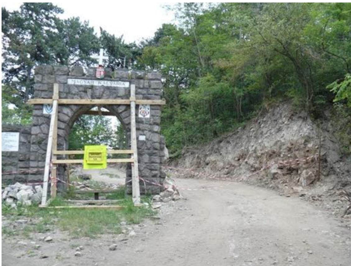
Fotografia 1 Kalwaria podczas remontu w 2014 roku.
