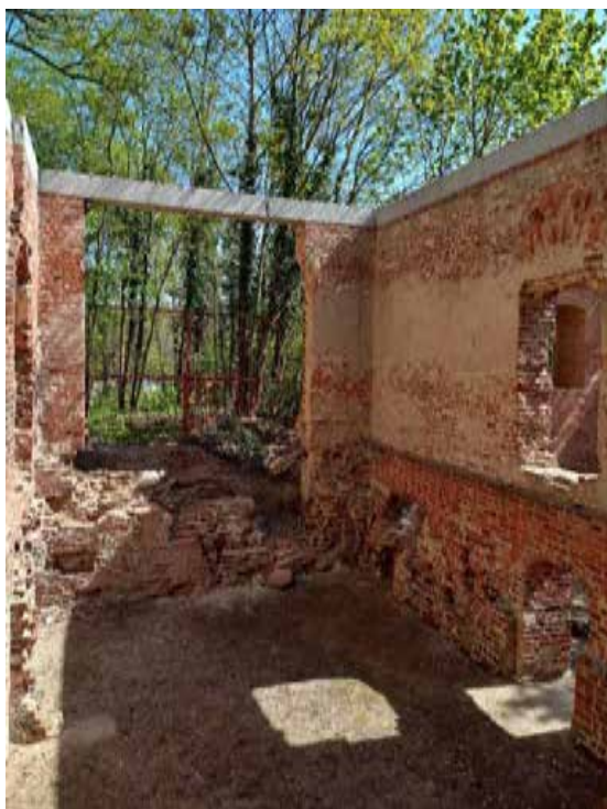
Fot. 75. Podczas rewitalizacji zabezpieczono strukturę murów (30.04.2026).
