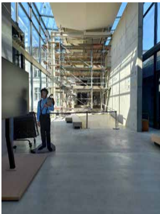
Fot. 21. Hol MP podczas remontu Galerii Romantycznej (14.08.2025).
