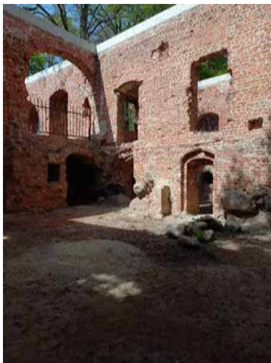
Fot. 76. Prace porządkowe objęły także piwnice (30.04.2026).
