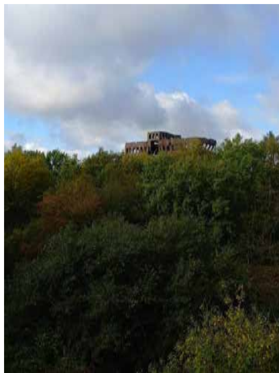
Fot. 94. Widok na młyn z dachu biurowca (16.10.2025).
