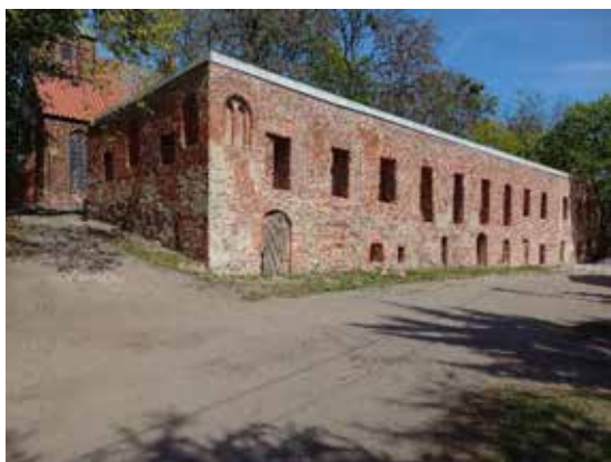
Fot. 77. Zewnętrzna ściana dawnego klasztoru po rewitalizacji. W tle kościół (30.04.2026).
