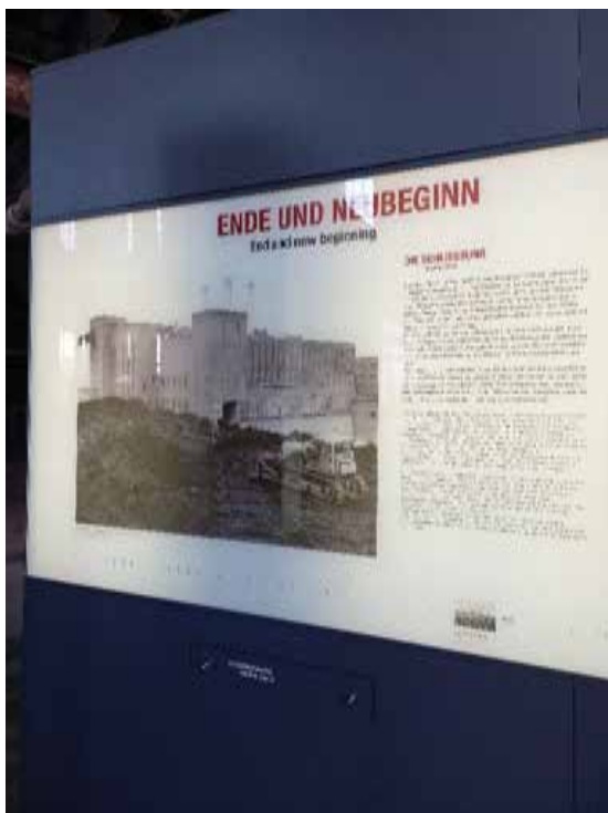
Fot. 119. Koniec i początek – elektrownia jako ostatni element systemu (16.08.2025).
