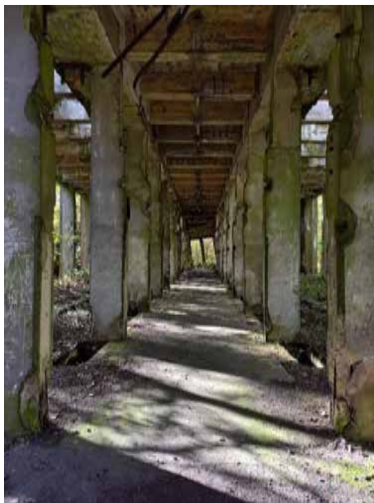
Fot. 98. Szkielet dawnej elektrowni (16.10.2025).
