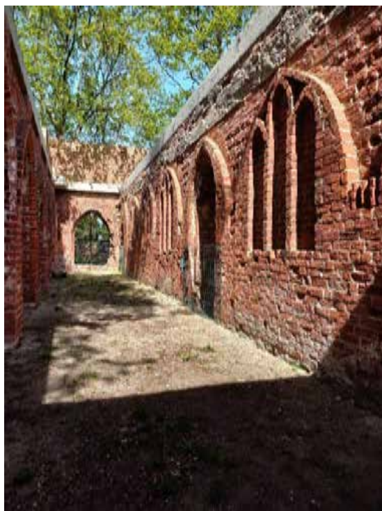
Fot. 74. To samo miejsce po zakończeniu prac rewitalizacyjnych w kwietniu 2026 roku (30.04.2026).
